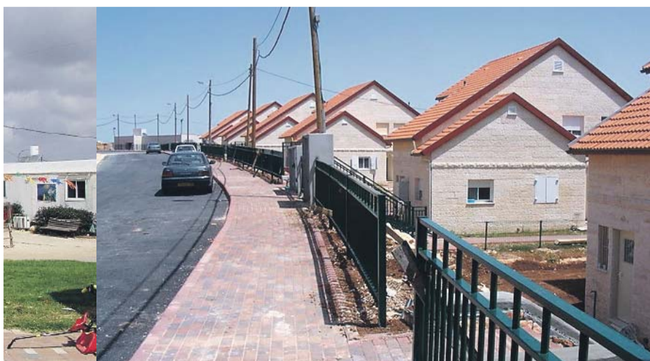
Omdat de huizen zo haastig zijn gebouwd, heeft de bovenverdieping geen ramen. Die worden er later alsnog in gezet.
